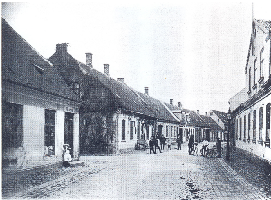
Adelgade ved Slotsgade. Til højre ses Adelgade 45, som blev nedrevet i 1912 ved Jernbanegades gennembrud. Ældre foto (Det kgl. Bibliotek)
