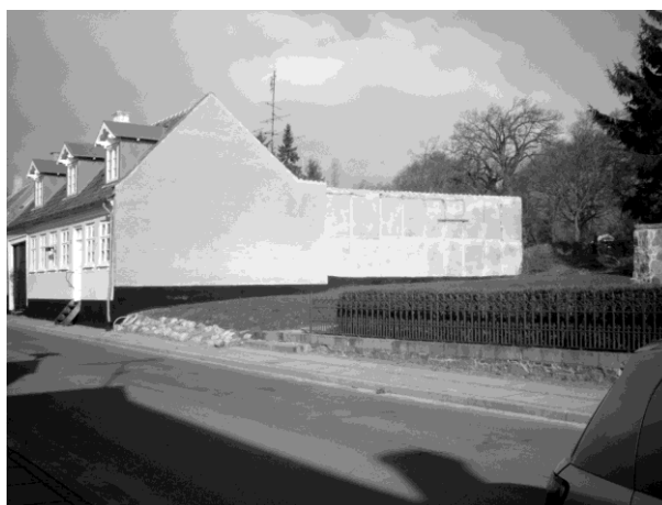
Nysted Menighedsråd købte i 1998 et hus i Adelgade og rev det ned for at skaffe plads til det nye sognehus, der efter skifteprojektet skal ligge her. Det bliver på 450 m 2 og skal rumme mødelokaler, handicaptoilet og kontorfaciliteter. Foto: John Voigt
