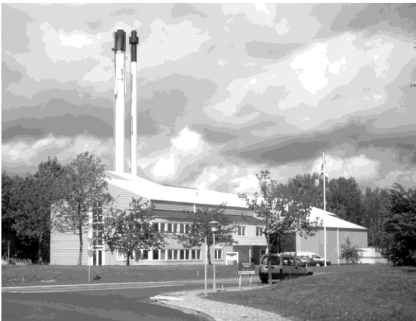
På billedet er den nye skorsten kommet på plads.
