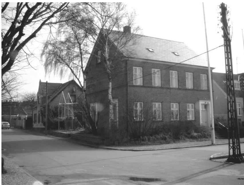
Bygherren har opsat et træskelet, som giver et billede af den fremtidige facade ud mod Havnegade.
