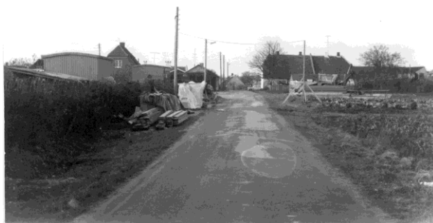
"Gartnerparken" under opførelse 1973 set fra Wichmandsvej.
