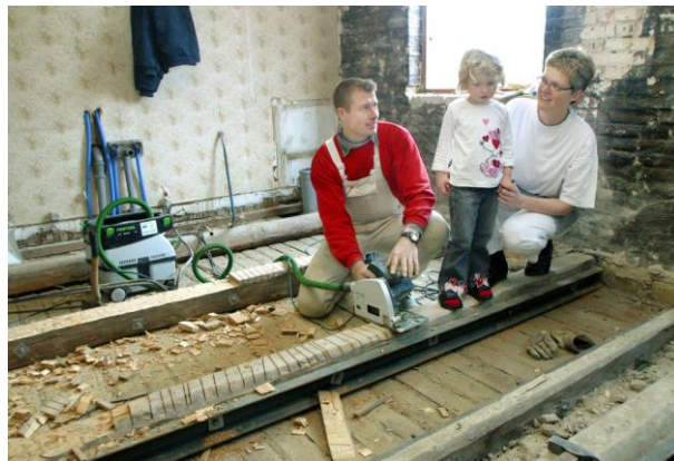
Tømrer Ken Frederiksen er i gang med badeværelset. Gitte og Silje ser til. Foto: Kim Løwenstein.
