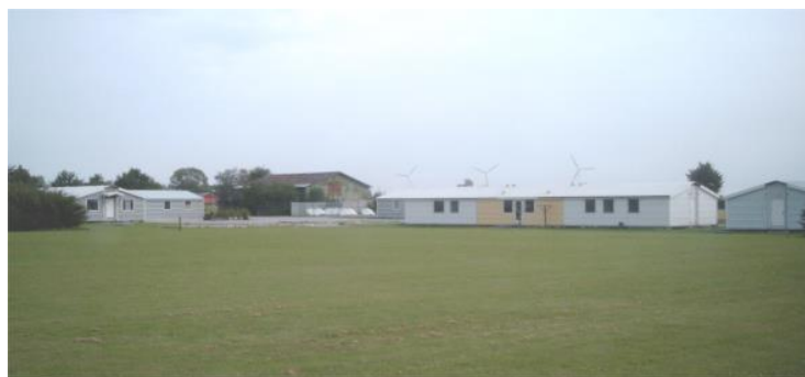
Nedrivningen er påbegyndt. Foto: John Voigt
