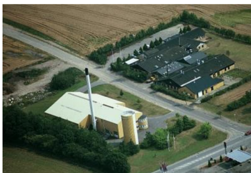
Nysted Halmvarmeværk set fra luften.
